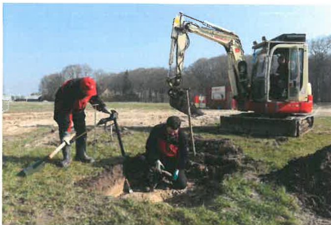
Benaderen objecten m.b.v. beveiligde graafmachine.
