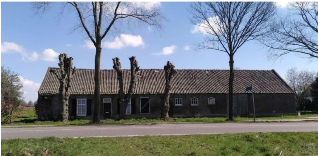
Figuur 1: Langgevelboerderij Liesselseweg 177
